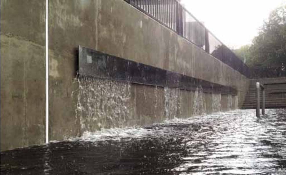
De 'watermuur' waardoor overtollig regenwater uit de omgeving het plein op stroomt.
